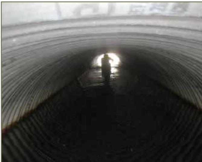
Photo 37. Ce grand tuyau de ponceau de 1,8 m partiellement rempli d'eau stagnante laisse entrer la lumière dans le tunnel, autoroute 24, Aurora, Ontario. © K. Gunson
