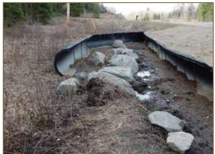
Photo 45. Extrémité de la clôture en U afin de dissuader les animaux qui longent la clôture d'aller sur la chaussée dans le comté de Haliburton © K. Gunson
