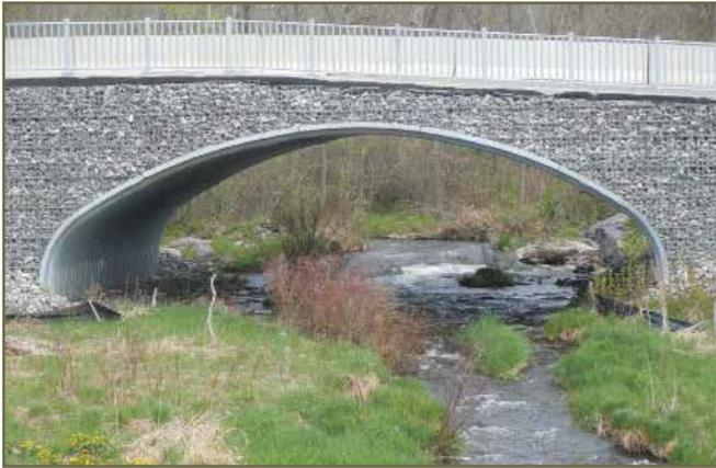
Photo 14 Tunnel arqué permettant l'écoulement d'un cours d'eau naturel © D. Seburn
