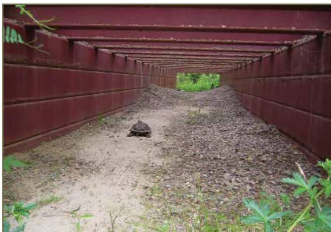
Photo 35. Une tortue qui emprunte un tunnel muni d'une grille ouverte avec un substrat naturel dans le fond. © A. Mui
