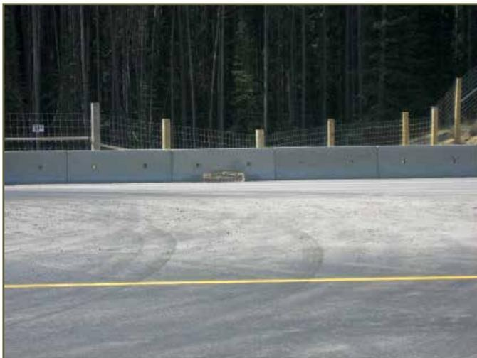
Photo 61. Barrière en jersey avec des orifices à la surface de la route ©K. Gunson
