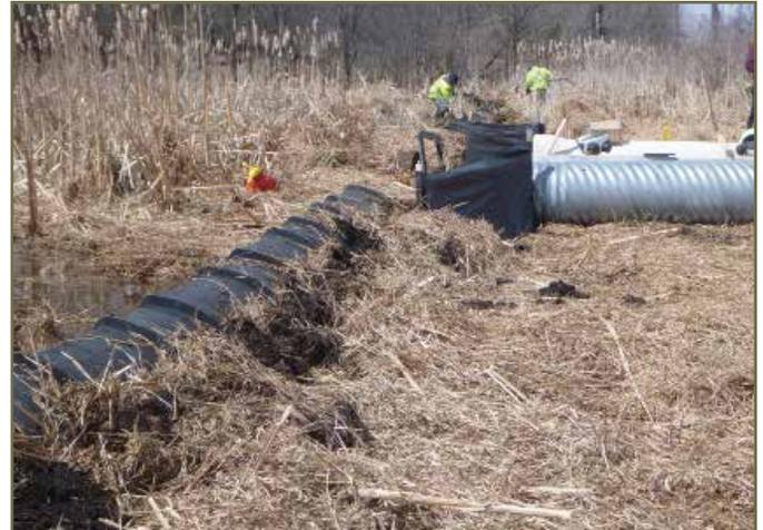
Photo 49. Un remblayage le long d'une clôture ACO pour la faune qui peut servir de rampe de fuite pour les animaux qui sont du côté de la route. © V. D'elia
