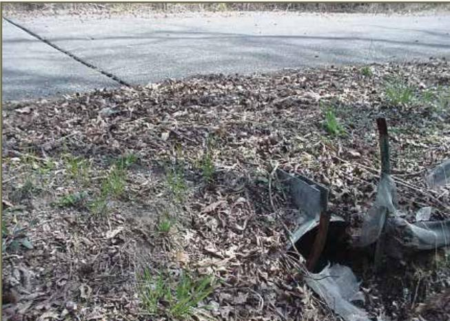
Photo 16. Un ponceau avec des fentes sur le dessus installé pour les crotales des bois dans l'Illinois, É.-U. © S. Ballard
