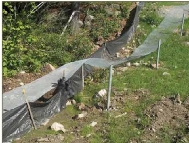
Photo 63. Clôtures temporaires posées avant l'installation de clôtures plus permanentes le long de l'autoroute 69. Notez le clôturage permanent réalisé dans la photo 48.
