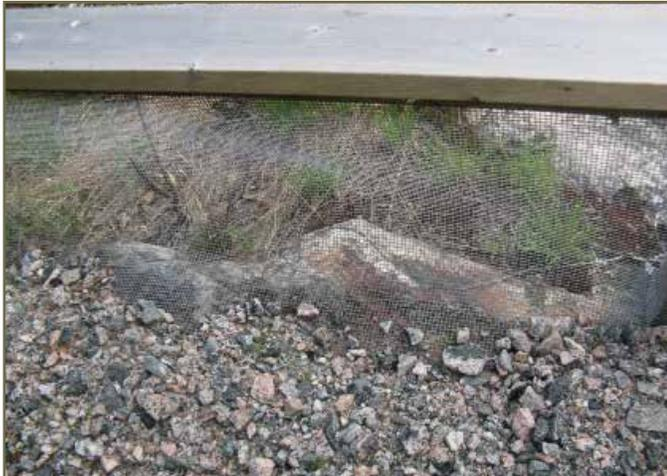
Photo 48. Une clôture le long du roc avec du gravier pour tenir la base de la clôture en place. © K. Gunson
