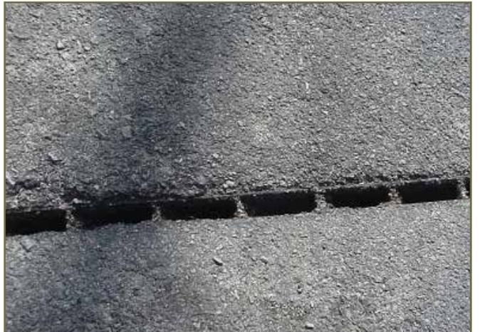
Photo 17. Zoom avant sur un ponceau à toit ouvert sur une route pour les crotales des bois dans l'Illinois, É.-U. © S. Ballard
