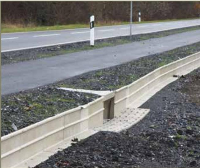
Photo 7. Variante à toit ouvert et fermé, Allemagne © ACO International
