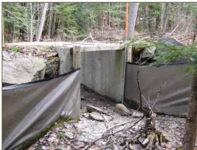
Photo 51. Clôture qui s'insère dans le tunnel sur la route Rice Lake Trail. À noter que la toile à ombrer n'est pas recommandée pour un clôturage permanent. © K. Gunson
