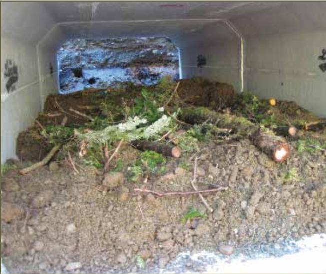
Photo 13. De la terre et des branches sur le fond d'un tunnel, Ucluelet, C. B.
