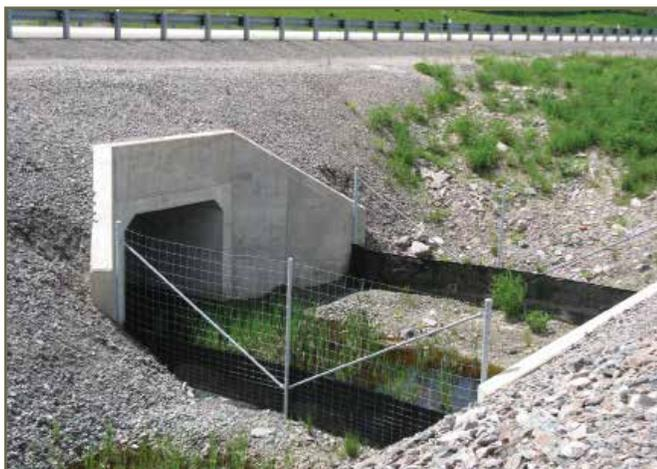
Photo 22. Tunnel de 3,4 m sur 2,4 m sur l'autoroute 69 © K. Gunson
