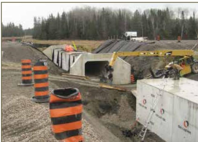
Photo 20. Ponceau rectangulaire en béton de 3,4 sur 2,4 m qui relie l'habitat de terres humides utilisé par les tortues sur l'autoroute 69. © K. Gunson
