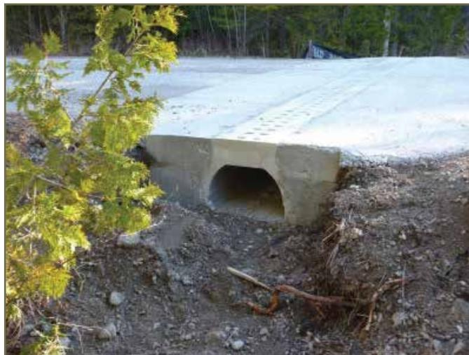
Photo 30. Terre excavée afin que l'entrée du tunnel soit au ras du sol. © D. Filip
