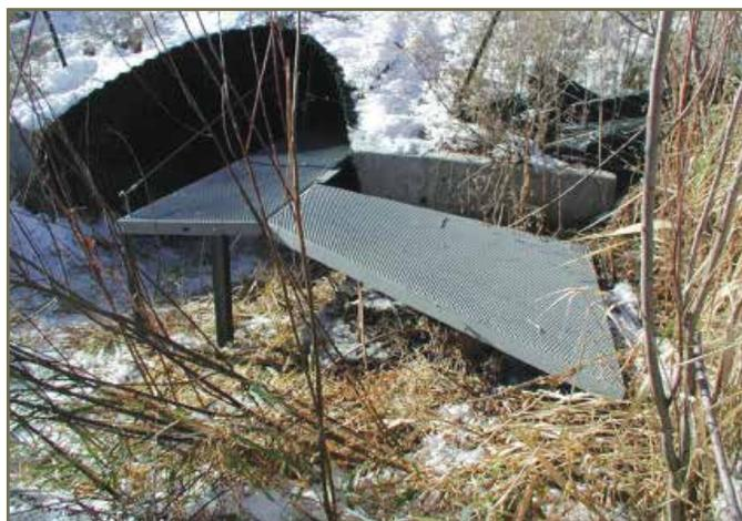
Photo 32. Banc sec dans tuyau de ponceau pour les petits animaux; il pourrait être modifié pour les serpents. © K. Foresman
