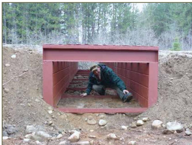
Photo 36. Une structure qui sert de tunnel avec des écrans de sédiments dans le fond. © B. Steinberg
