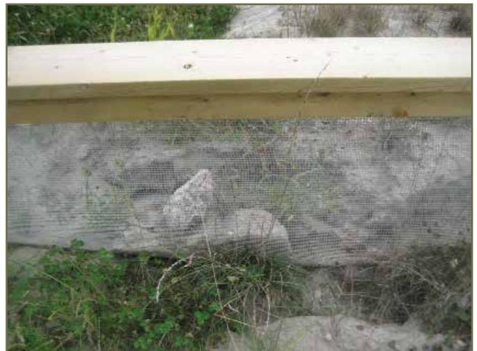
Photo 39. Grillage métallique avec une maille de ¼ pouce, charpente en bois et bordure supérieure. © K.Gunson
