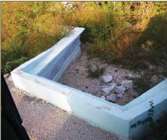
Photo 11. Tunnel dont les murs de tête sont reliés à des garde-fous en béton à Cuba. © G. Barrett
