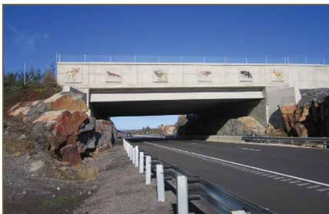
Photo 26. Passage supérieur pour la faune sur l'autoroute 69 qui révèle une base dans le roc. © K. Gunson.
