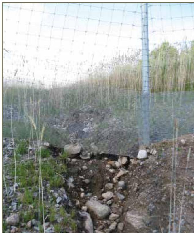
Photo 50. Clôture avec un espace dans le bas causé par l'érosion de l'eau qui s'écoule sous la clôture. © K. Gunson
