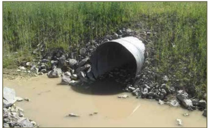
Photo 46. Une accumulation d'eau à l'entrée d'un ponceau qui devrait être évitée aux tunnels terrestres destinés à la faune. © K. Gunson
