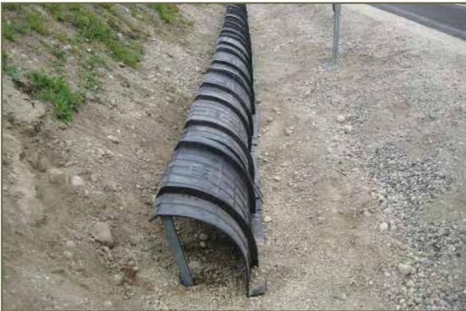
Photo 42. Clôture ACO sur l'autoroute à proximité d'Oliver, C.-B. © R. Guse
