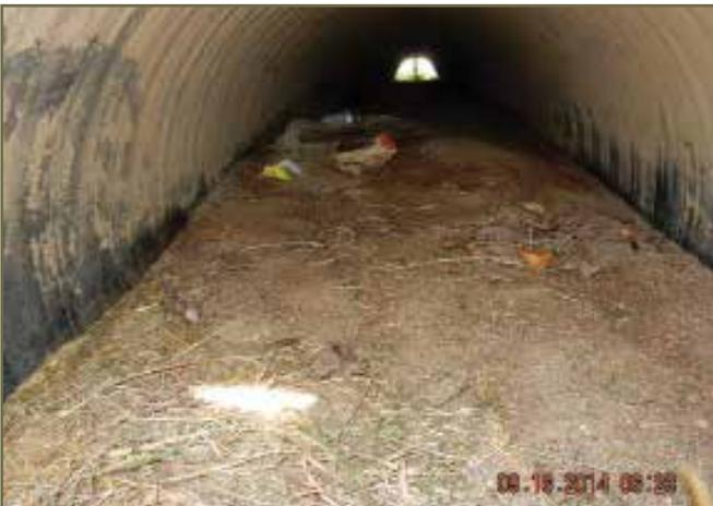
Photo 18. Ponceau circulaire en plastique enterré permettant un plancher terrestre plane en Suède © K. Gunson
