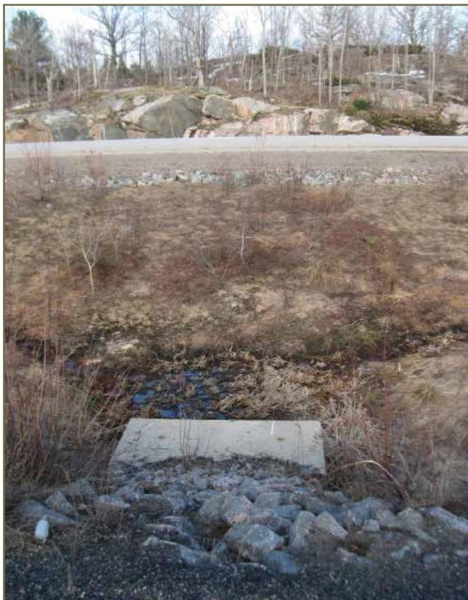
Photo 27. Tunnel de drainage rectangulaire laissé ouvert dans un terre-plein le long de l'autoroute 69 © K. Gunson
