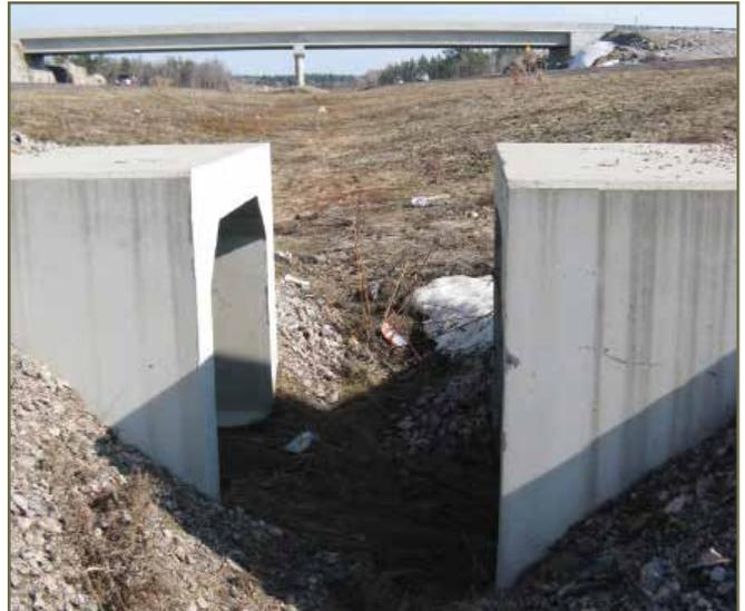
Photo 10. Tunnels rectangulaires dans un terre-plein central qui devraient être reliés par une clôture lorsqu'ils doivent servir d'écoducs. © K. Gunson
